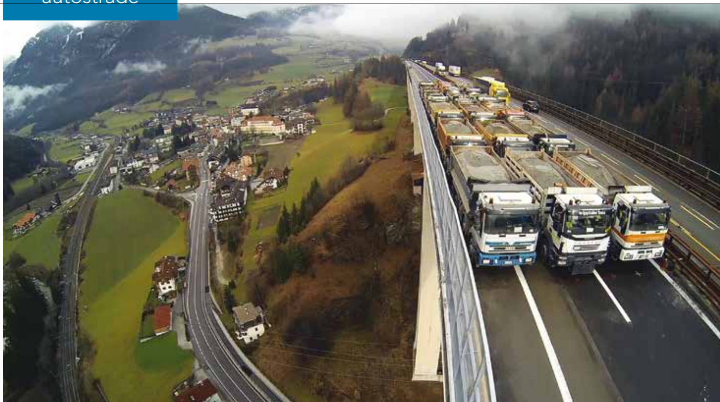
3. Le prove di carico dopo la manutenzione al viadotto Colle Isarco
