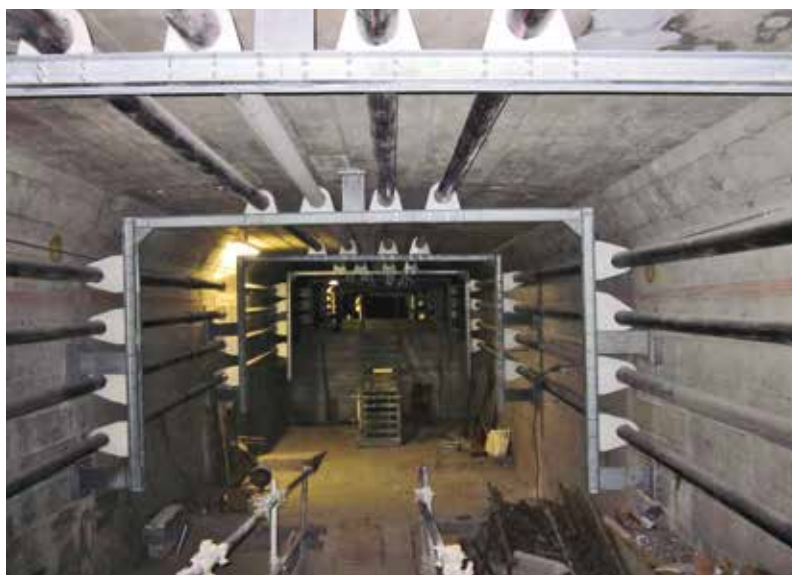
1. L'interno del viadotto Colle Isarco
