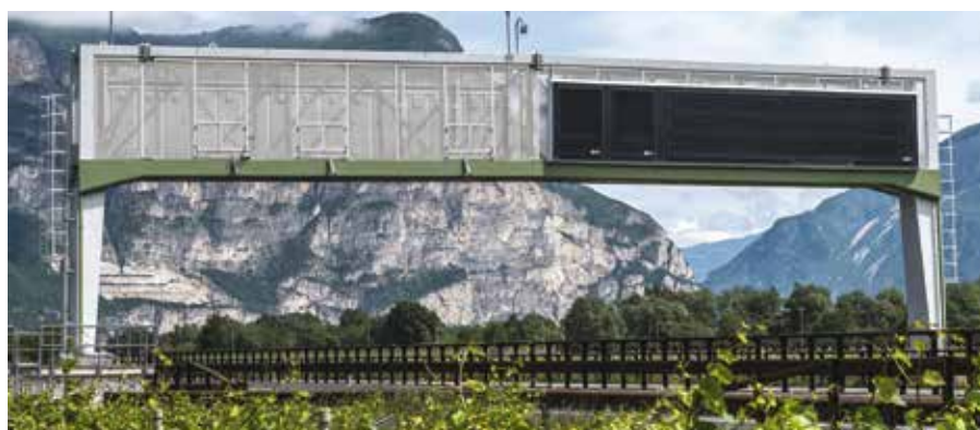
2. I pannelli a messaggio variabile sono già stati dotati di Road Side Unit (l'antenna centrale)
