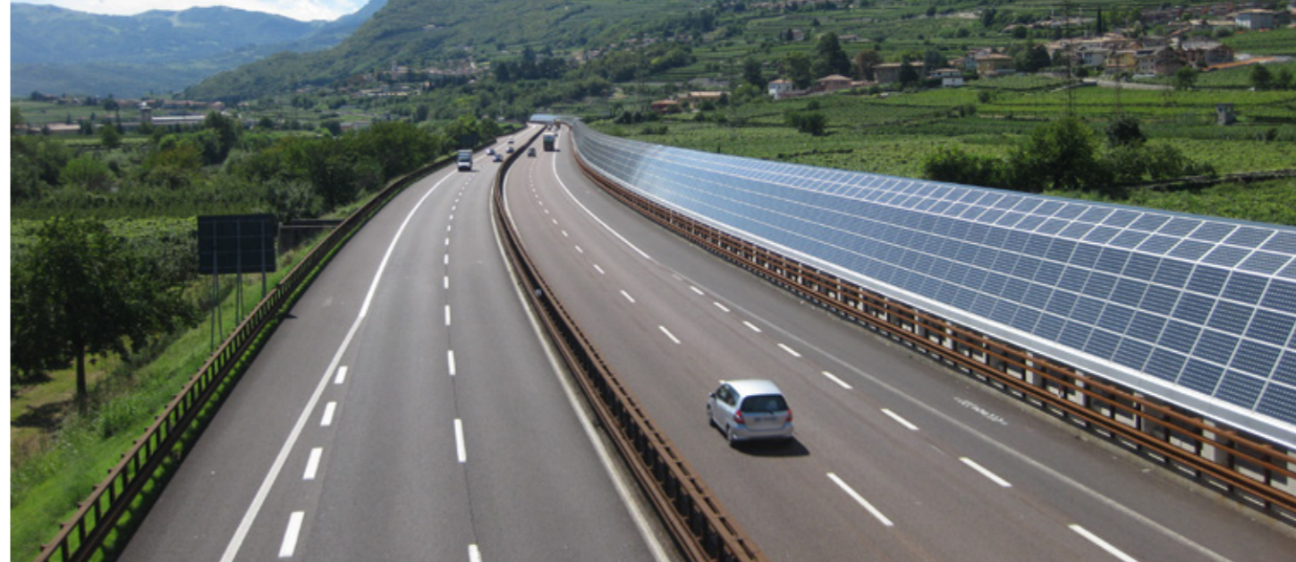
Barriera fotovoltaica antirumore in località Isera
