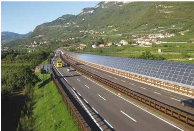
2. La barriera fotovoltaica antirumore di Isera
