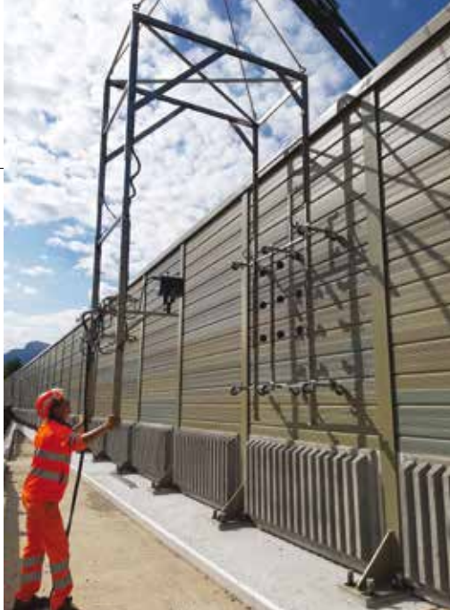
2. La fase di posizionamento della staffa
