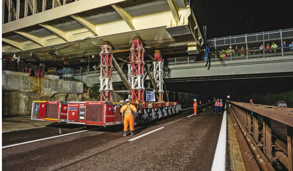
2. Il varo del sovrappasso: le operazioni sono durate solo 3 ore e 15 minuti
