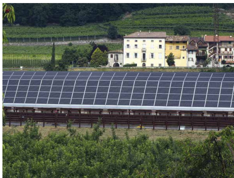
4. La barriera antirumore fotovoltaica nei pressi di Isera (TN)
