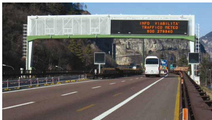
2. I pannelli a messaggio variabile orienteranno i viaggiatori sull'attivazione e disattivazione della corsia dinamica
