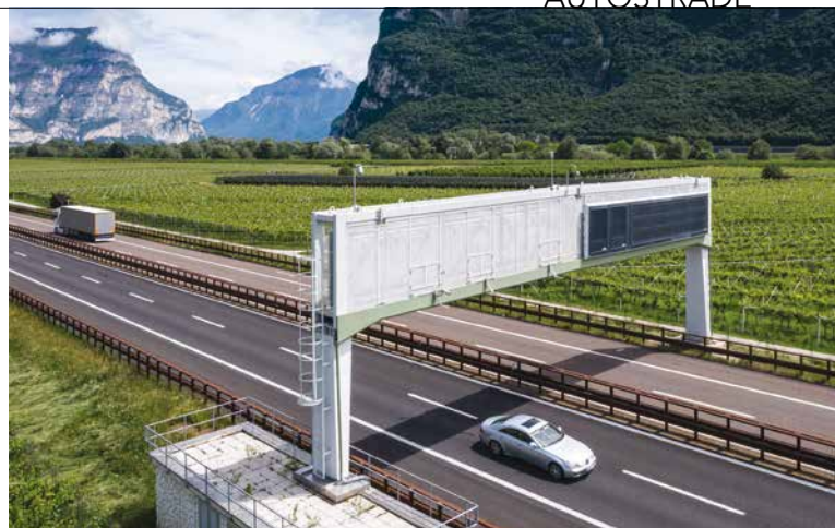
4. Sensori per la rilevazione del traffico, PMV e telecamere forniranno l'apporto tecnologico indispensabile alla terza corsia dinamica
