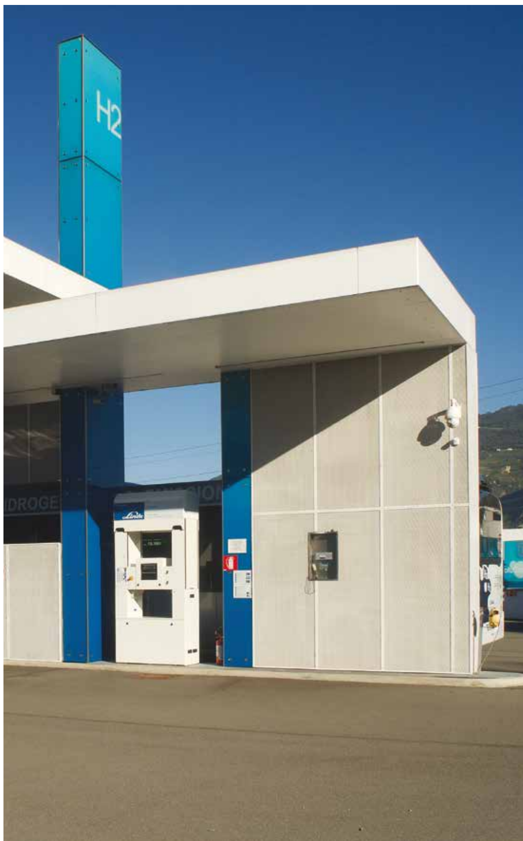
Stazione di rifornimento dell'idrogeno
