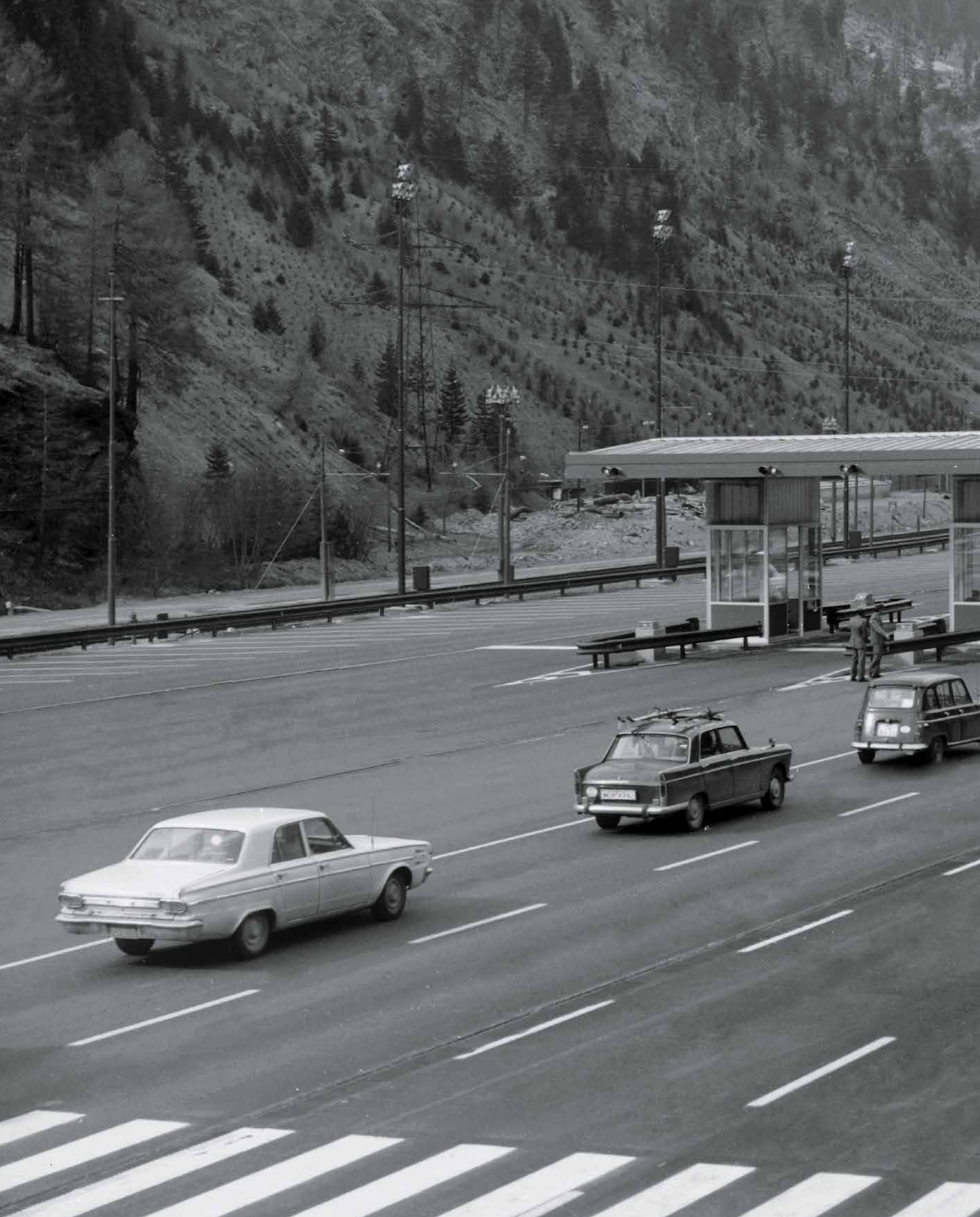
la stazione autodoganale del Brennero realizzata in occasione della costruzione dell'autostrada
