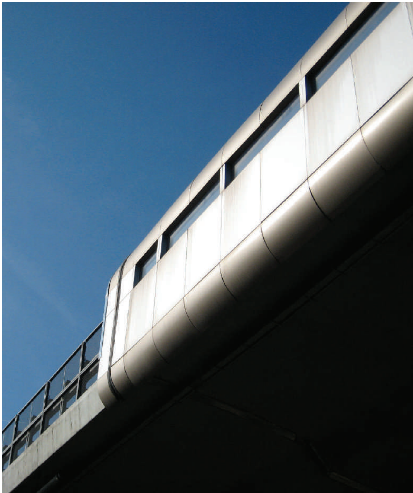
SUL VIADOTTO DI BOLZANO LA BARRIERA ANTIRUMORE RIVESTITA DA LASTRE DI ALLUMINIO ANODIZZATO CREA UN EFFETTO AVVOLGENTE
