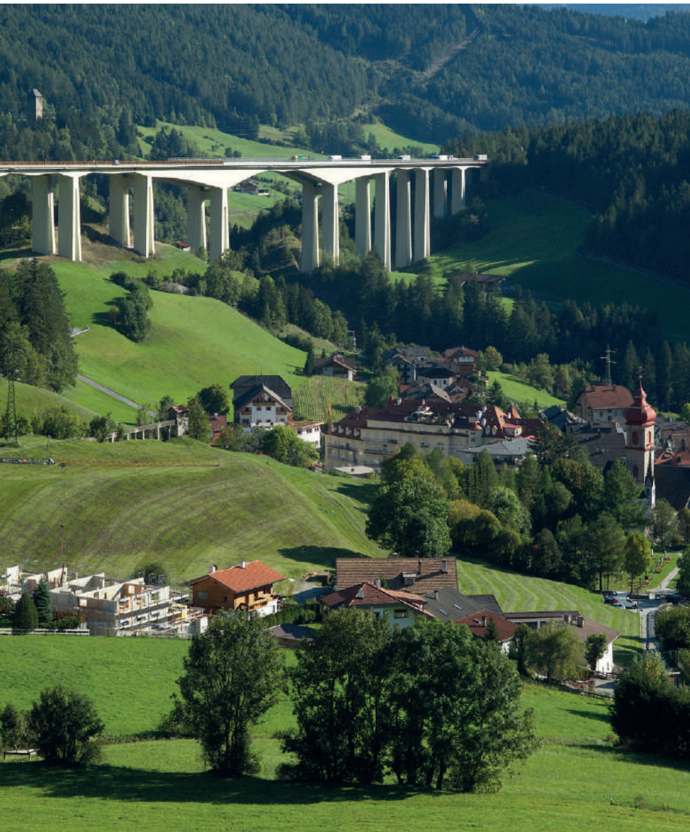
IL VIADOTTO DI COLLE ISARCO: LUNGO 1.028 METRI, SI ARTICOLA IN 13 CAMPATE
