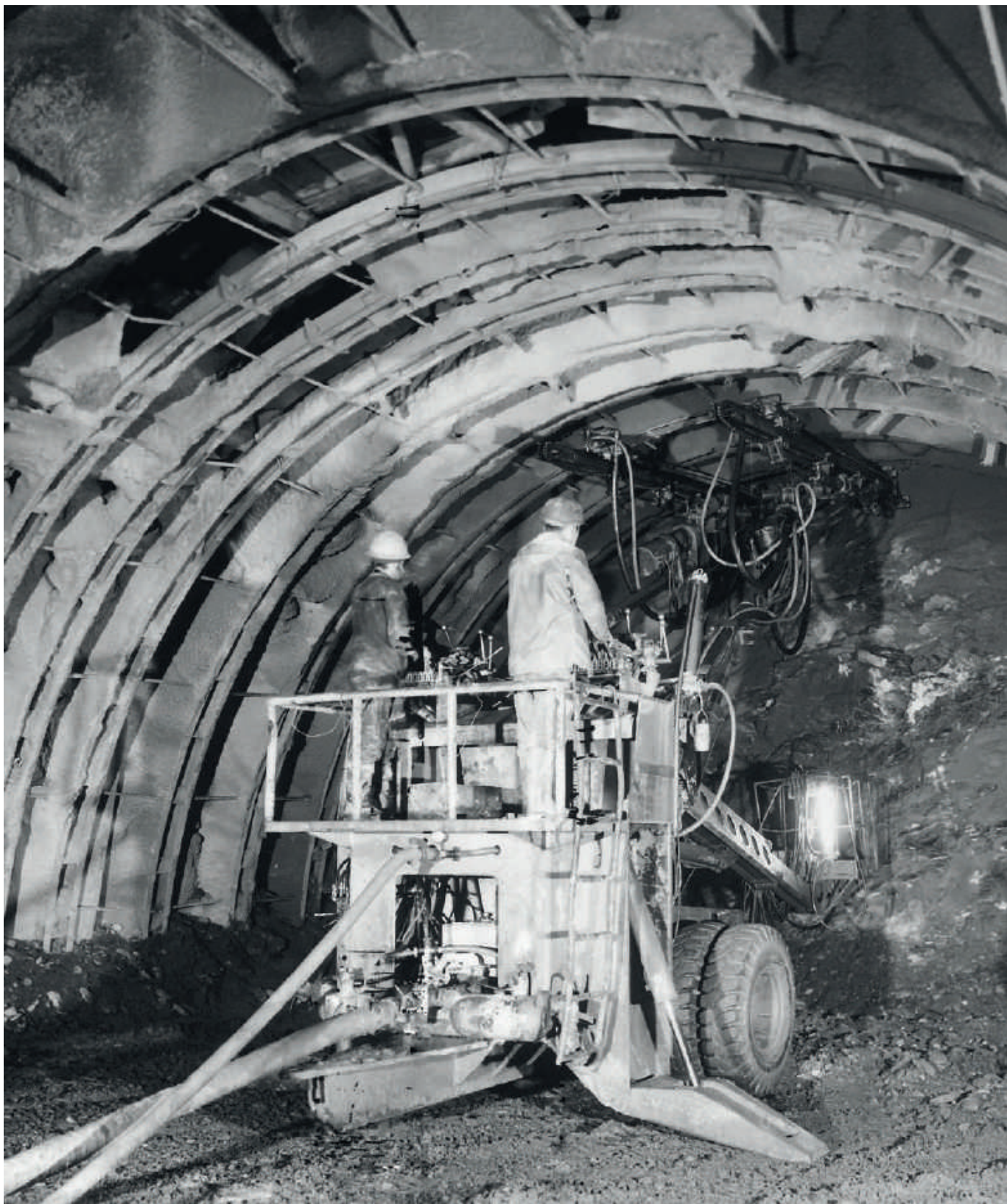
LAVORI DI SCAVO DI UNA GALLERIA NEL TRATTO CHIUSA-BOLZANO
