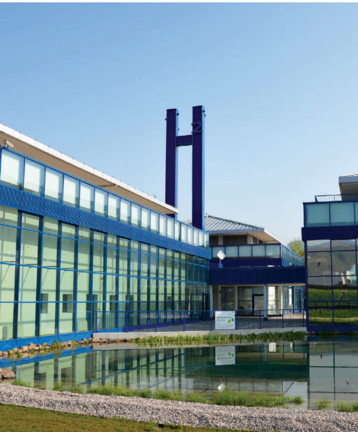
IL CENTRO DI PRODUZIONE E DISTRIBUZIONE DELL'IDROGENO NEI PRESSI DELLA STAZIONE AUTOSTRADALE DI BOLZANO SUD
