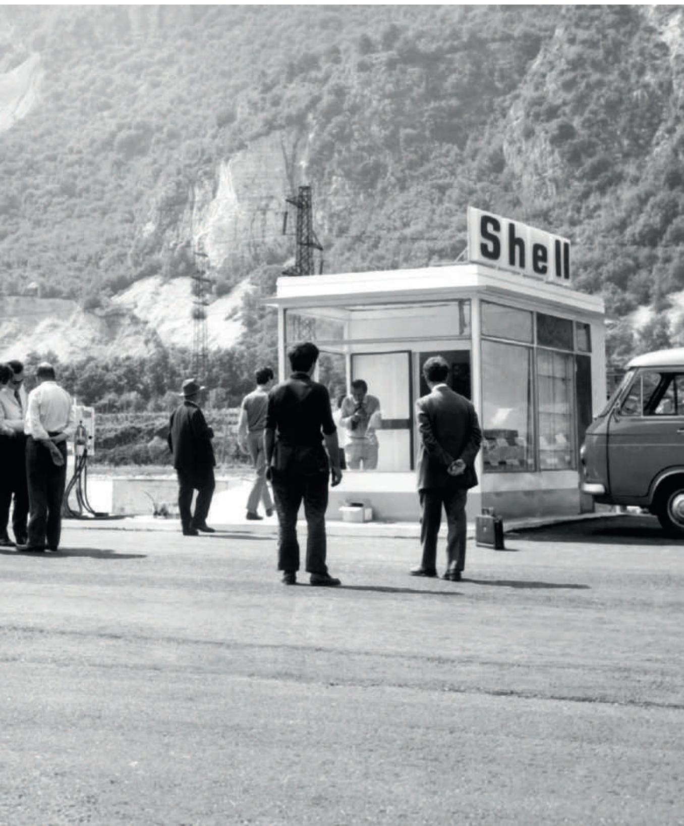
UNO DEI PRIMI DISTRIBUTORI DI CARBURANTE DI UN'AREA DI SERVIZIO DELL'A22
