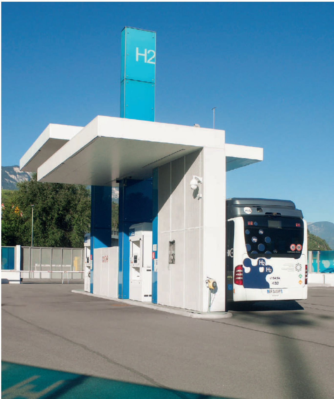
UN AUTOBUS A IDROGENO IN RICARICA PRESSO LO STABILIMENTO DI BOLZANO SUD, IL PRIMO E UNICO IMPIANTO DI PRODUZIONE E DISTRIBUZIONE DI IDROGENO GREEN IN ITALIA
