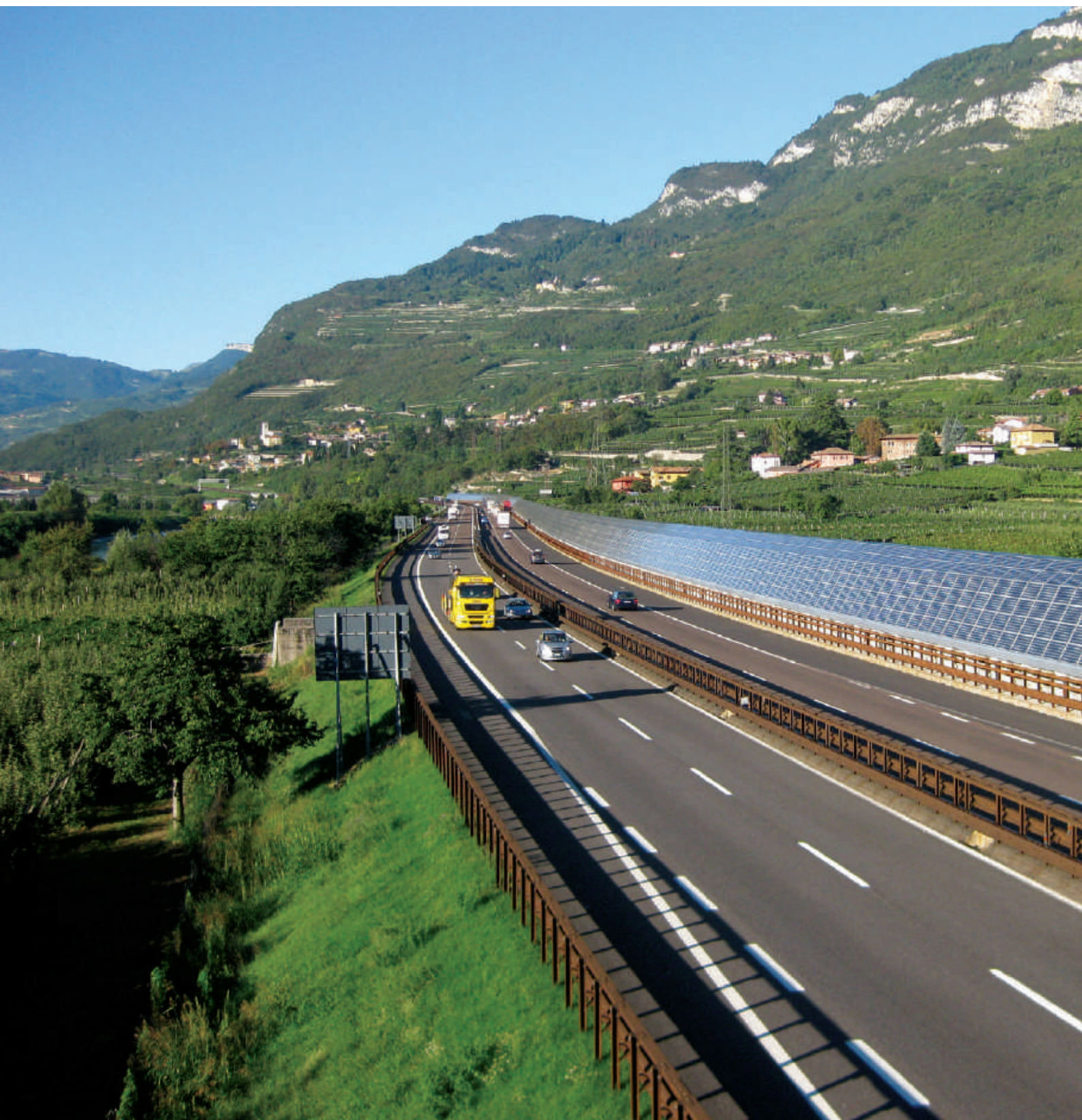
VEDUTA AEREA DELLA BARRIERA ANTIRUMORE FOTOVOLTAICA AD ALTA EFFICIENZA REALIZZATA A ISERA NEL 2009
