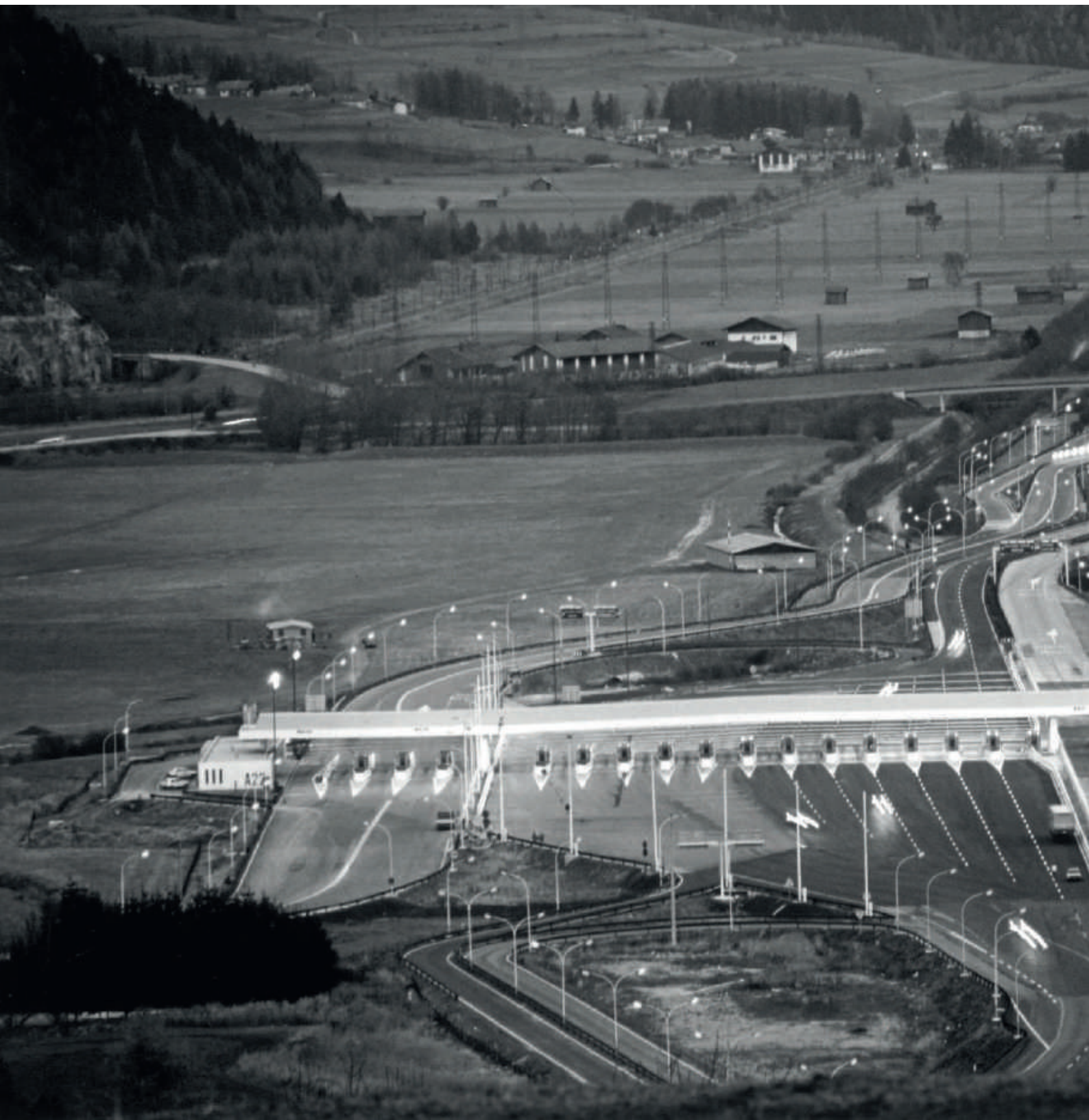
UN'IMMAGINE NOTTURNA DELLA NUOVA BARRIERA AUTOSTRADALE BRENNERO DI VIPITENO POTENZIATA NEL 1987 CON 22 PISTE
