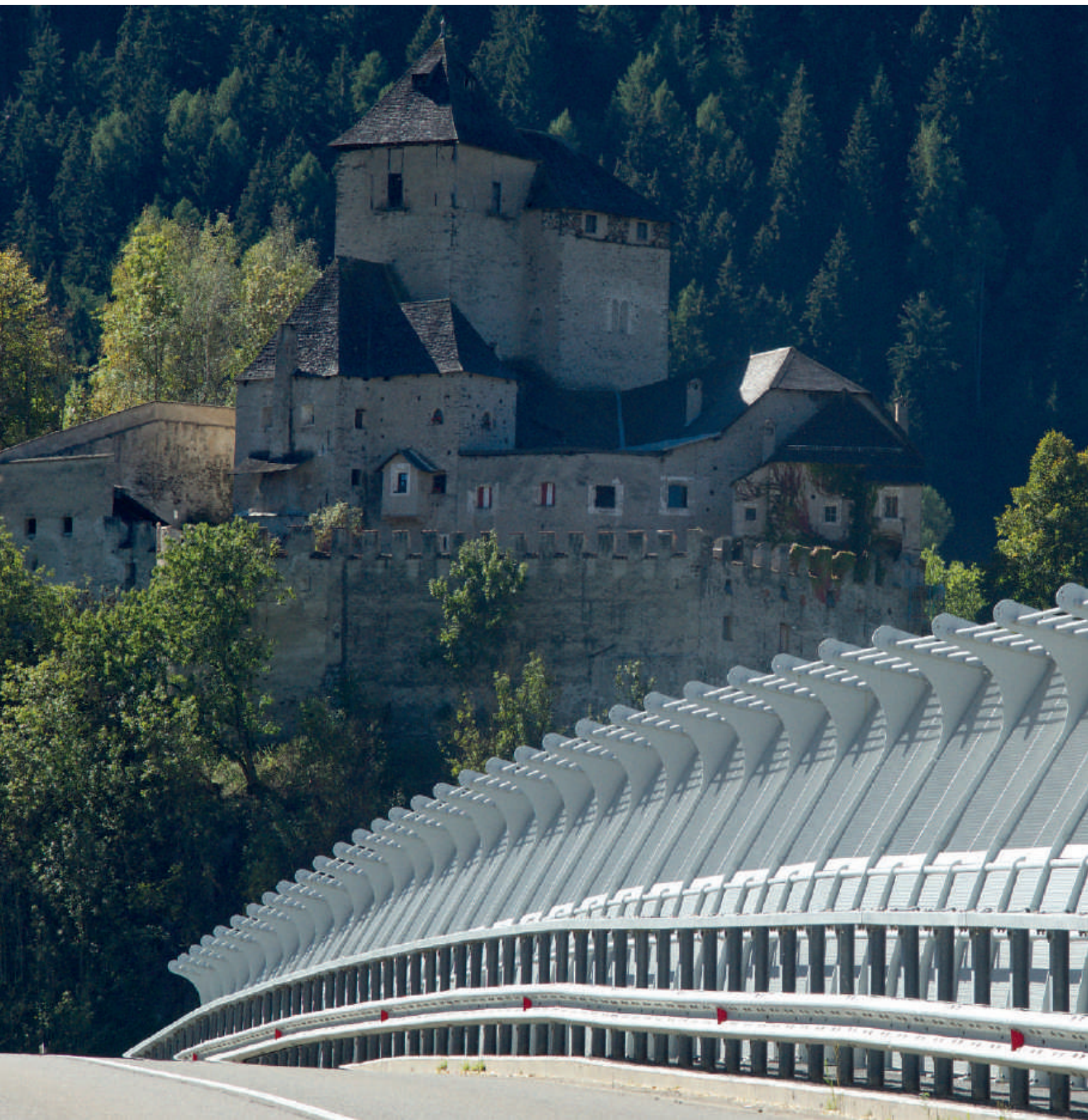
IL SOVRAPPASSO DEL RIO RIDANNA NEI PRESSI DI PRUNO (CAMPO DI TRENS) IN ALTO ADIGE
