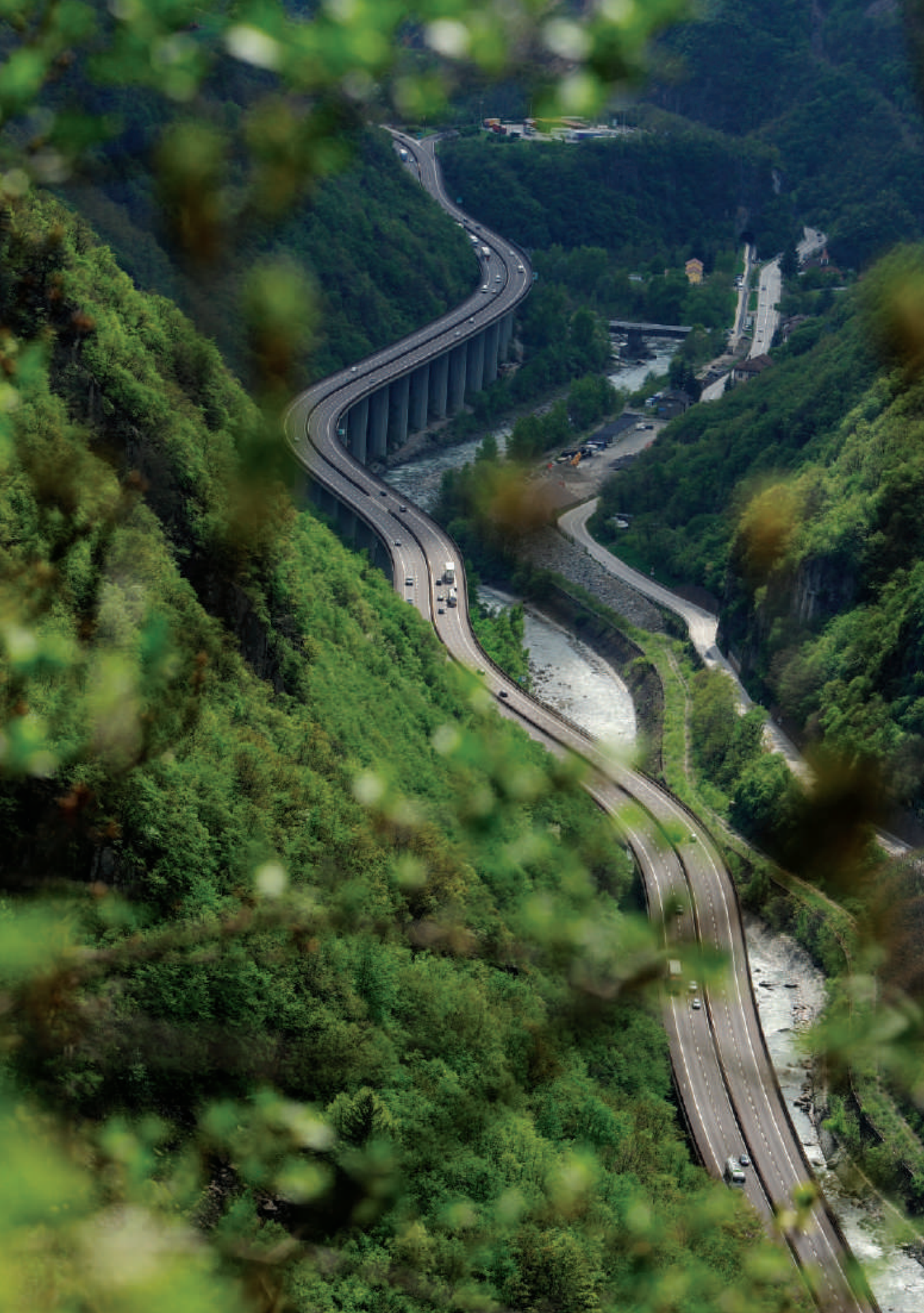
IL VIADOTTO DI CAMPODAZZO, LUNGO 2,4 KM CON 69 CAMPATE DI 35 METRI DI LUCE
