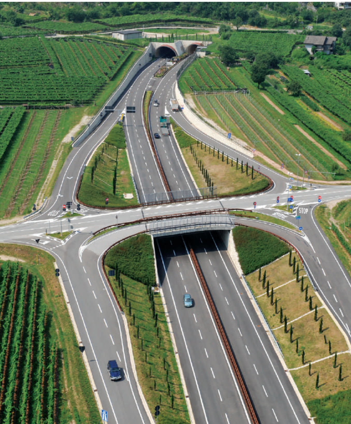
VEDUTA AEREA DELL'OPERA DI RACCORDO CHE COLLEGA LA STAZIONE AUTOSTRADALE DI ROVERETO SUD CON LA STRADA STATALE 240 VERSO IL LAGO DI GARDA
