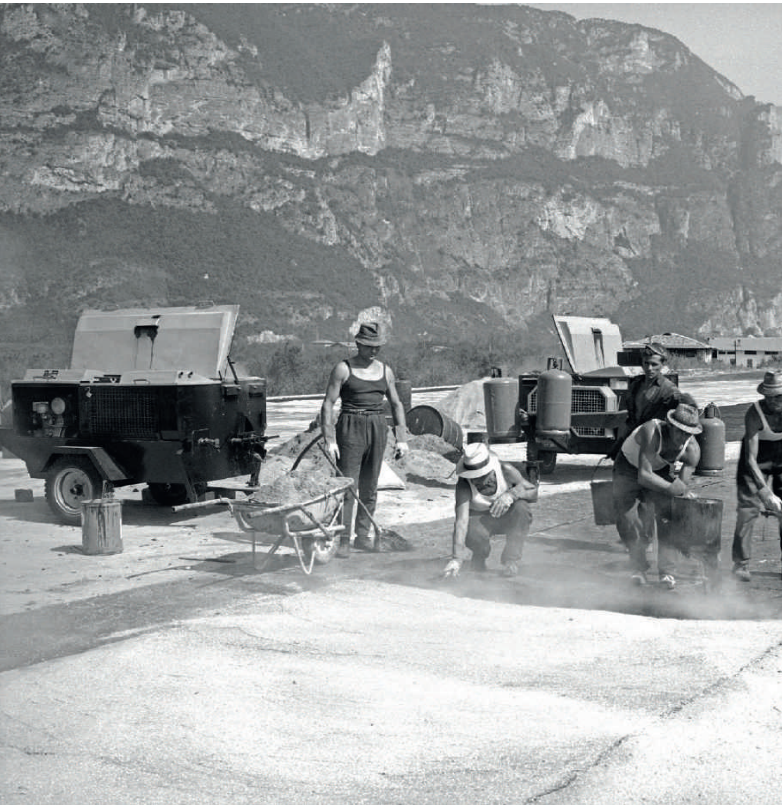
LAVORI DI ASFALTATURA DEL PONTE AUTOSTRADALE SUL FIUME ADIGE, NEI PRESSI DI ZAMBANA (TRENTO)
