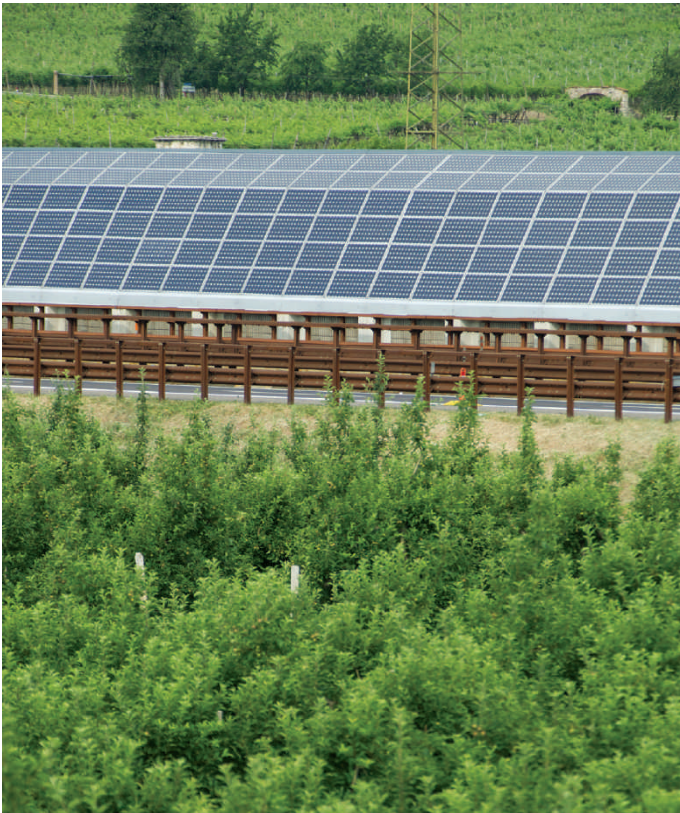
UNO SCORCIO DELLA BARRIERA ANTIRUMORE FOTOVOLTAICA A ISERA TRA LE COLTIVAZIONI
