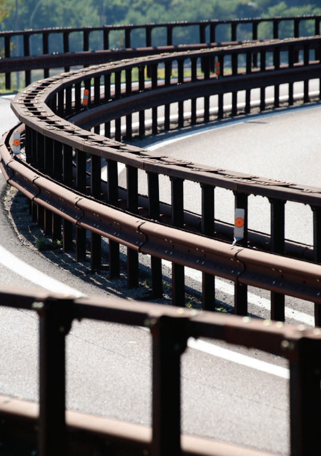
LA BARRIERA DI SICUREZZA IN ACCIAIO CORTEN TIPICA DELL'AUTOSTRADA DEL BRENNERO
