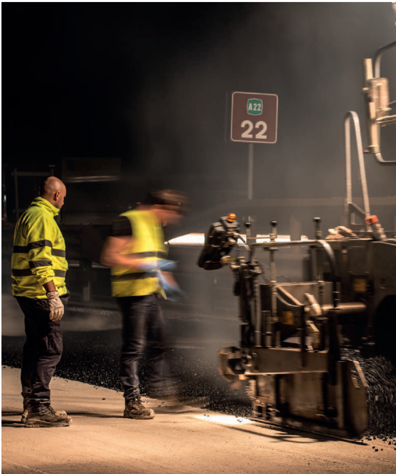
LAVORI DI ASFALTATURA LUNGO L'AUTOBRENNERO: L'ASFALTO UTILIZZATO DALLA SOCIETÀ È QUASI ESCLUSIVAMENTE DI TIPO DRENANTE FONOASSORBENTE
