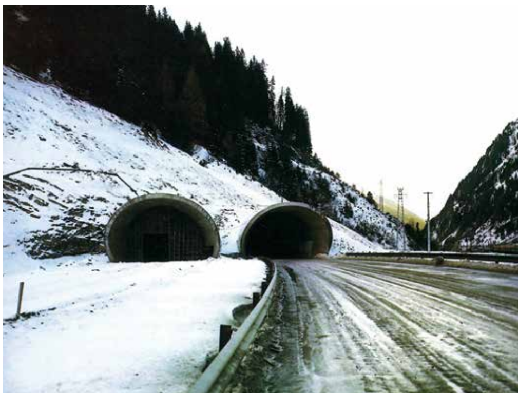
Sopra: Imbocco delle gallerie al Passo del Brennero. Sotto: Tronco Brennero-Cave di Fortezza. Il viadotto «Ponticolo 1».
