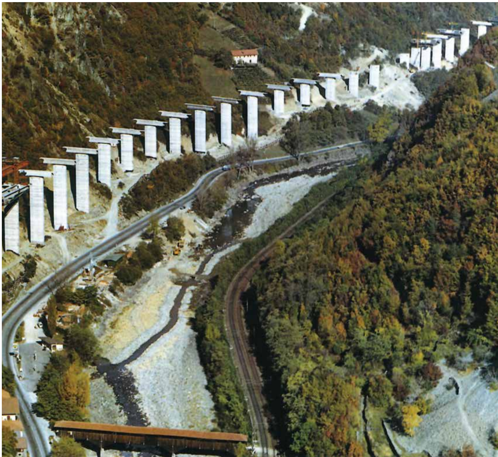
Chiusa-Bolzano: Pile in costruzione del viadotto.
