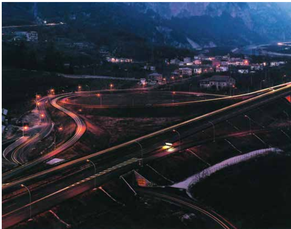
Sopra: Svincolo a Trento di notte. Sotto: Raccordo con l'autostrada Serenissima.
