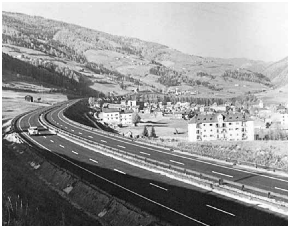
Sopra: Veduta panoramica dell'autostrada nei pressi di Vipiteno. Sotto: Attraversamento dell'abitato di Bressanone.
