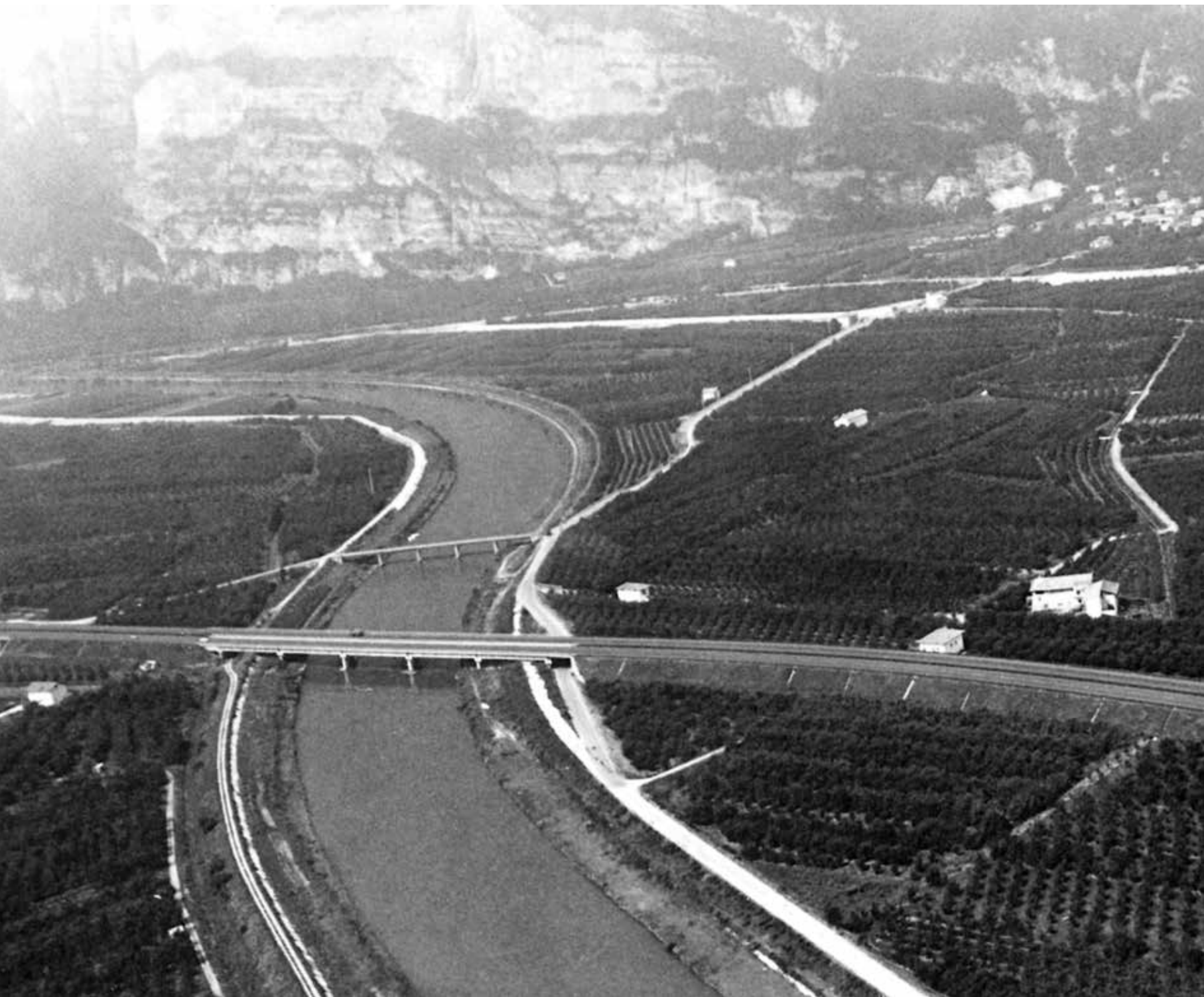
Tronco: Bolzano Sud-Trento Nord. Veduta panoramica dell'autostrada con il ponte di Zambana.
