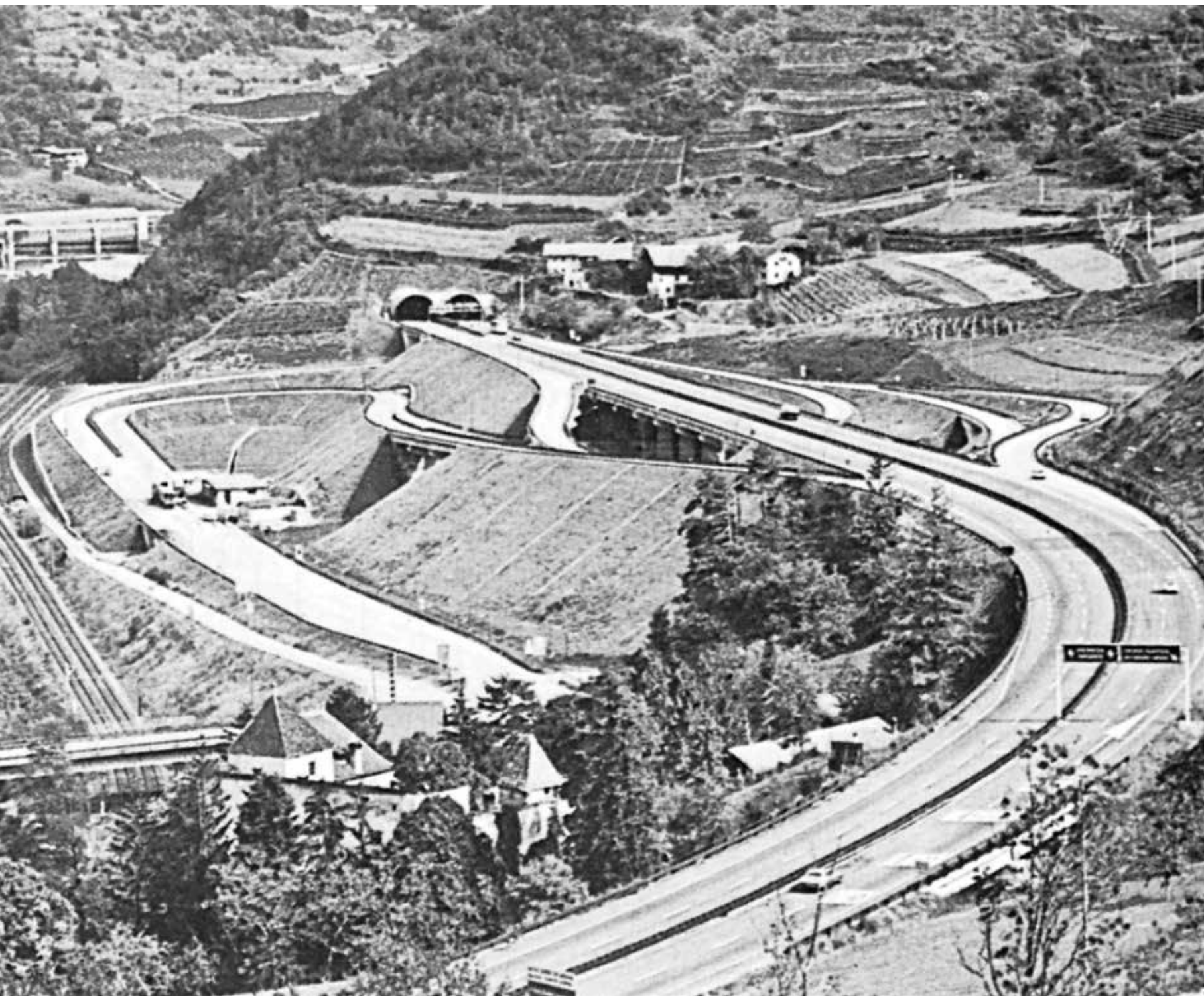
Svincolo di Chiusa.
